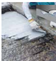
コンクリート床版 断面修復工法
