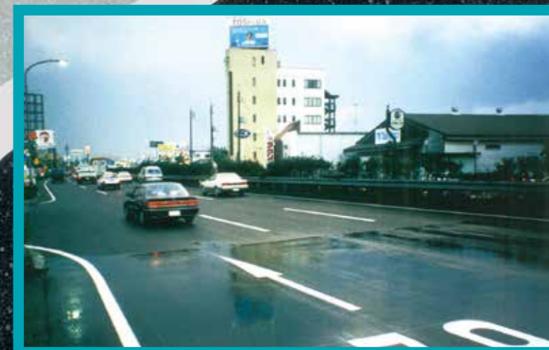
国道2号 岡山新保排水性舗装
