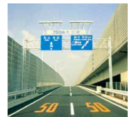
国道298号 三郷排水性舗装
