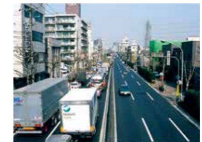
東京都 世田谷羽根木排水性舗装
