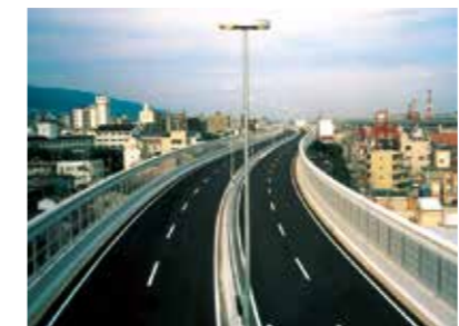
阪神高速道路 3号神戸線排水性舗装
