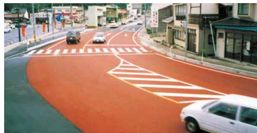
国道9号 浜田カラー排水性舗装
