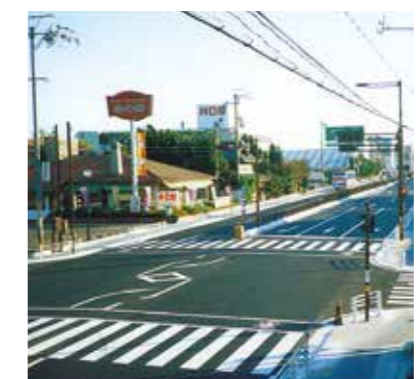
国道258号 築捨改良排水性舗装
