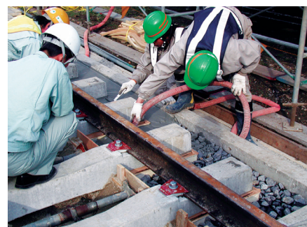
※防振まくらぎとRWG-Nを使用した省力化軌道の施工例
