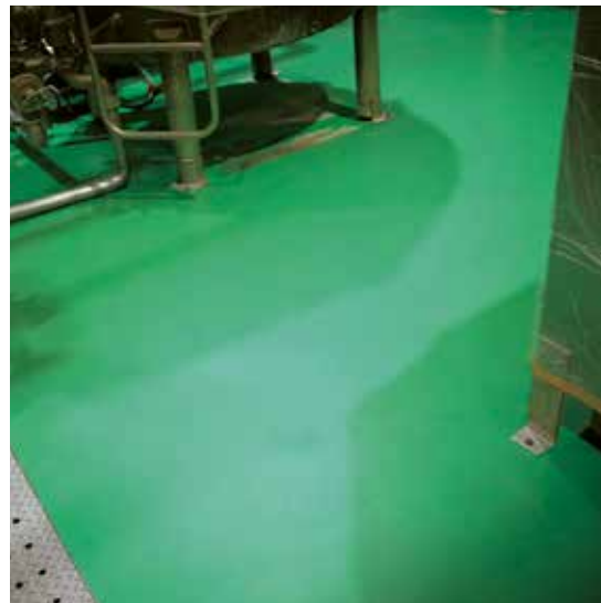
ペースト工法、平滑タイプ施工例
