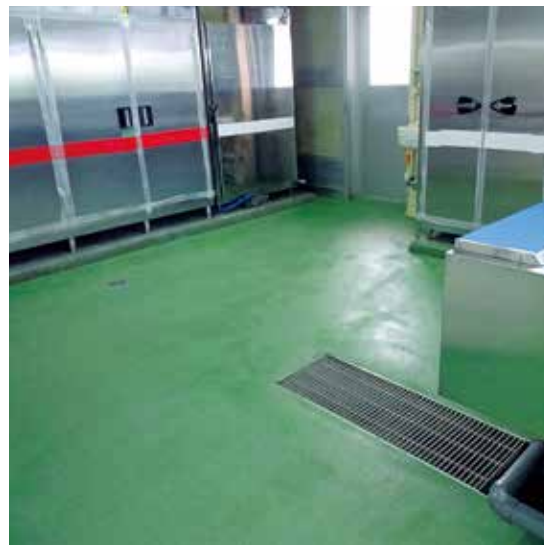
モルタル薄塗り工法 防滑タイプ施工例
